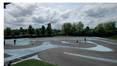
Rénovation de la piste de vitesse. Chacun met la main à la pâte pour un bon nettoyage et réfection de la peinture.
